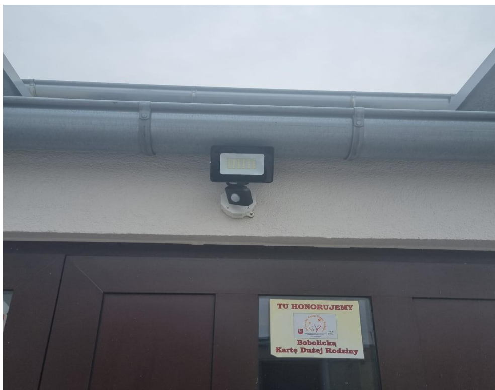
Zakup i montaż oświetlenia zewnętrznego na budynku MGOPS w Bobolicach
