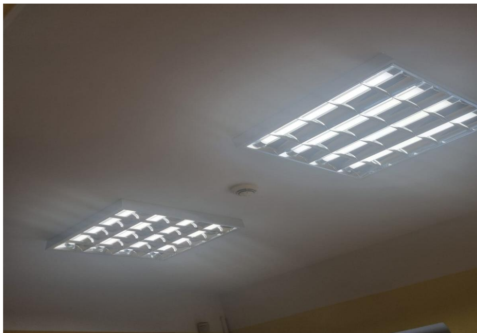
Wymiana lamp oraz naprawa oświetlenia w MGOPS w Bobolicach
